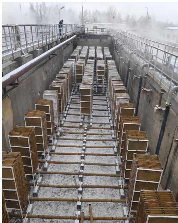
Рис. 2. Коридор после ремонта и модернизации кассет
